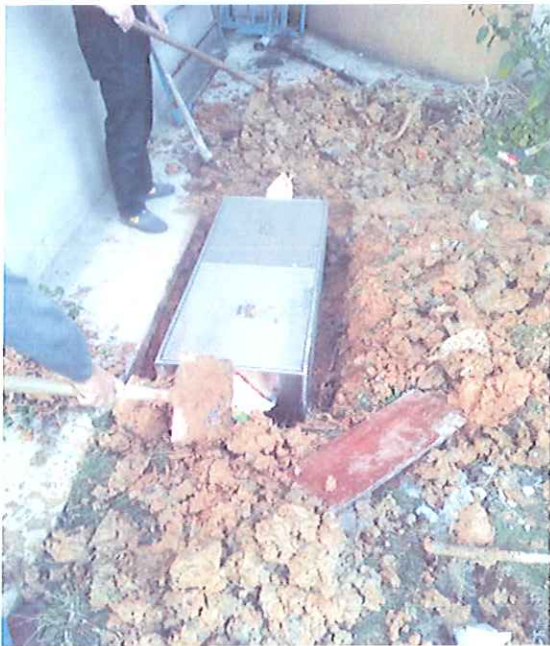
隔油池施工现场
